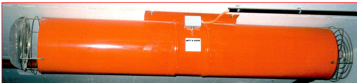
Witt & Sohn Parkgaragen-Lüfter Ø 400 mm mit beidseitigen Schalldämpfern Witt & Sohn parking garage fan Ø 400 mm with inlet and outlet silencers
